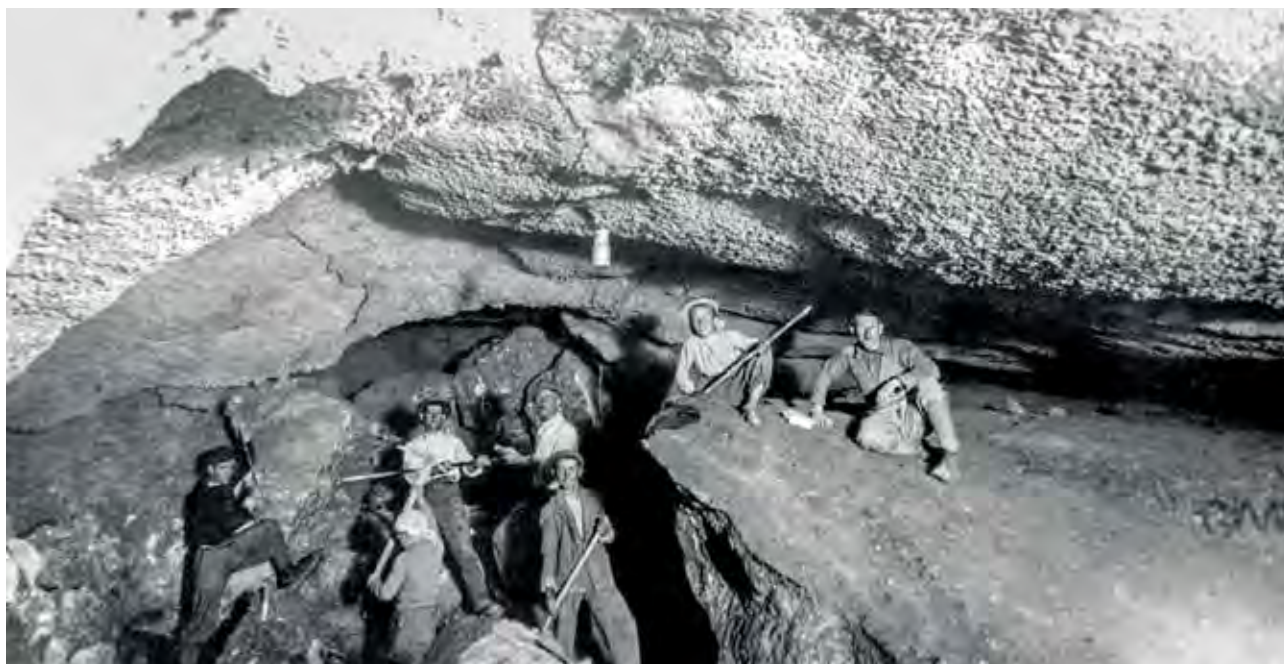
Grotta della Spipola: i lavori di adattamento turistico della cavità, condotti dal GSB nel 1935-'36. La rimozione della frana di massi che occupava il fondo della Sala delle Ossa, alla base della seconda rampa di scale. A sinistra dei minatori, Giulio Greggio; a destra del gruppo, Luigi Fantini. (Foto di Luigi Fantini).
