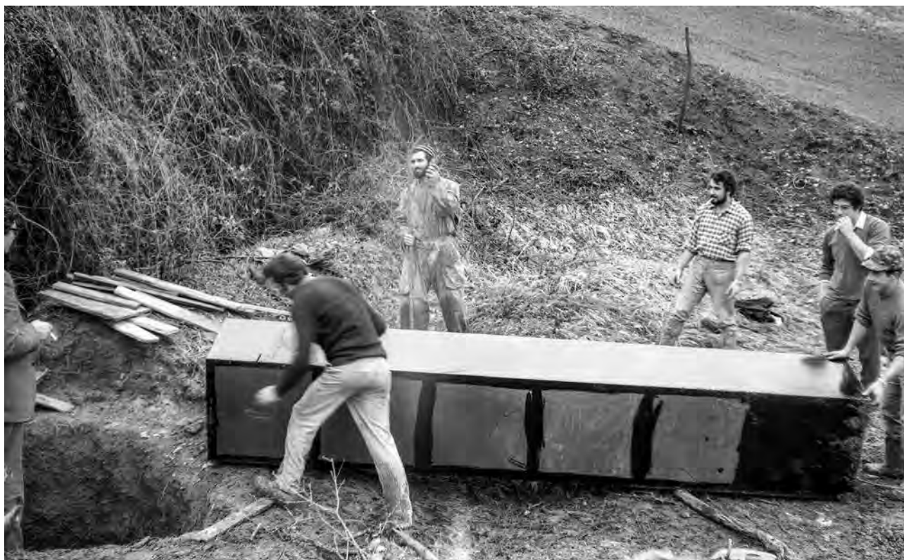
1972: installazione dello scatolare metallico di protezione all'imbocco della Grotta delle Pisoliti. Nell'immagine compaiono Andrea Morisi, Giordano Canducci ed Aurelio Pavanello, dell'USB (Foto di Claudio Busi).
