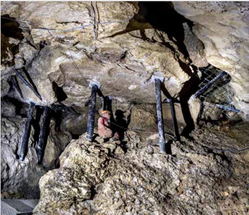
Strutture di consolidamento e cavi elettrici nel tratto turistico della Grotta di Onferno. Nella cavità si sono manifestati, nel tempo, problemi di instabilità che hanno reso necessari cospicui interventi di consolidamento ed ovviamente, trattandosi di grotta turistica, l'installazione di un impianto di monitoraggio statico in continuo.
